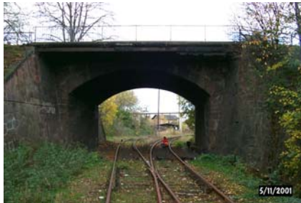
BW 12 vor der Instandsetzung
