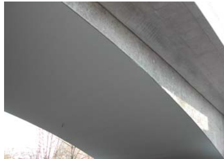
Überbau BW 13 nach Betoninstandsetzung
