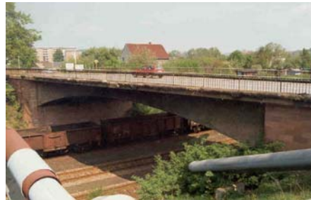
und BW 13 vor Instandsetzungsbeginn
