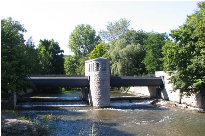
Blick auf die Wehranlage von Unterstrom
