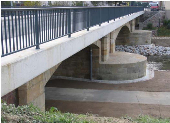
Ansicht Unterstrom BW 8 Muldebrücke
