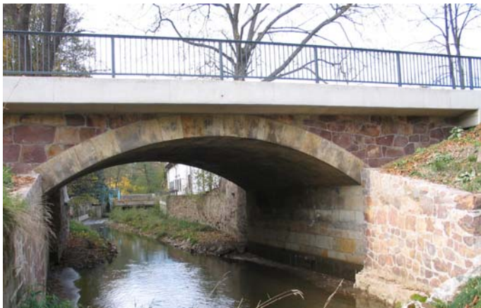
Ansicht Oberstrom BW 7 Mühlgrabenbrücke
